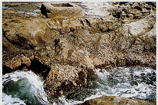
海水が生きている飛沫帯
